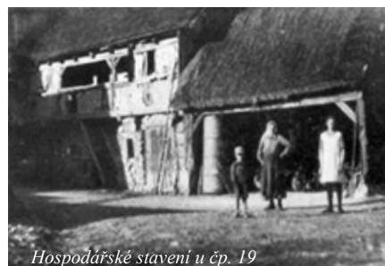
Hospodářské stavení u čp. 19
